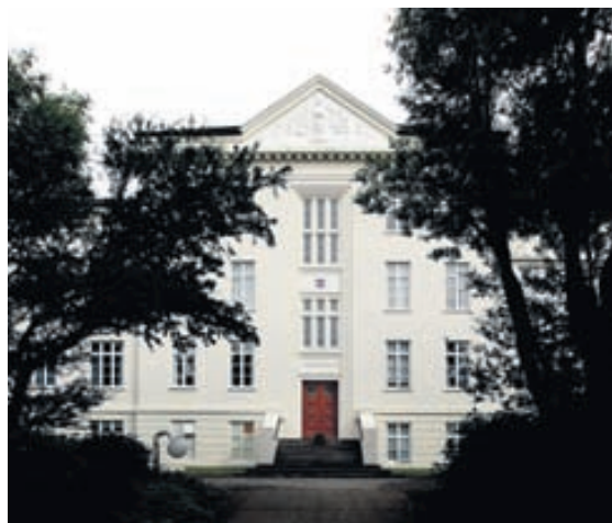
Landspítalinn var tekinn í notkun 1930 eftir fimm ára byggingartíma.
